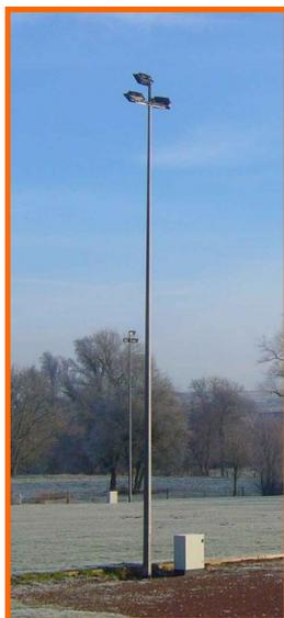
Depuis octobre 2007, le terrain d'entraînement de football est équipé d'un éclairage performant. Le dispositif comporte 4 mâts portant sur chacun 3 cellules électriques orientables.
